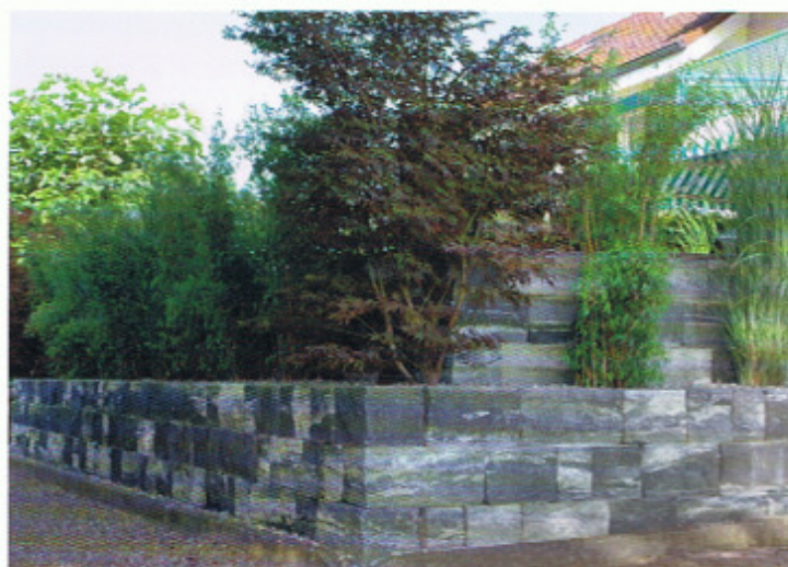
Die VERZASCA® Felsmauer als bepflanzte Terrassenmauer
